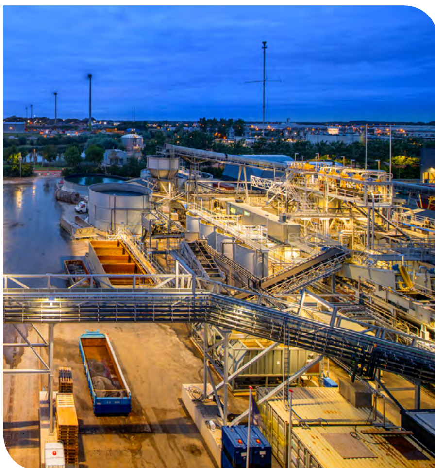
Bodemasswasinstallaties van HVC in Alkmaar
